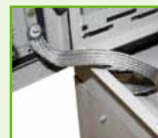
Ground and equipotential bonding
